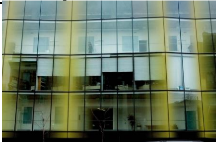
Photo : Annik MH De Carufel - Le Devoir Les locaux de la TELUQ dans un édifice de l'UQAM. L'établissement, basé à Québec, recouvrira sa pleine autonomie au sein du réseau UQ. Robert Dutrisac
