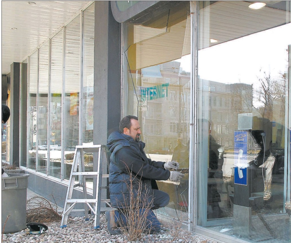
■ Les vitriers s'affairaient à réparer les dommages causés par les casseurs au centre-ville.
